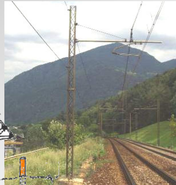
**1000 V – Kabel zur Versorgung bahneigener Anlagen
