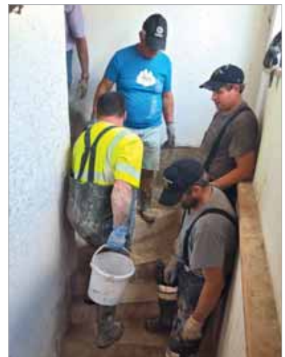
Aufräumarbeiten nach Unwetter
