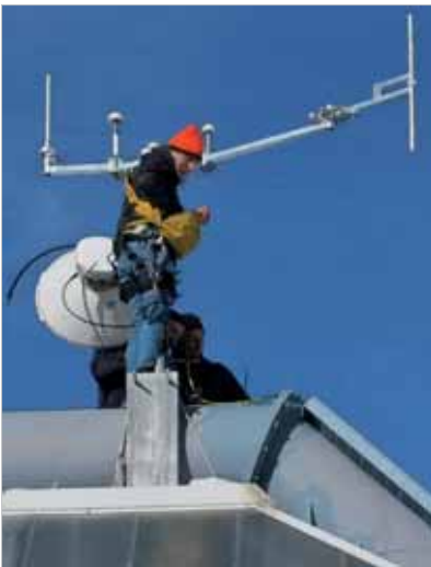
Installation POCSAG Basisstation Obereggen
