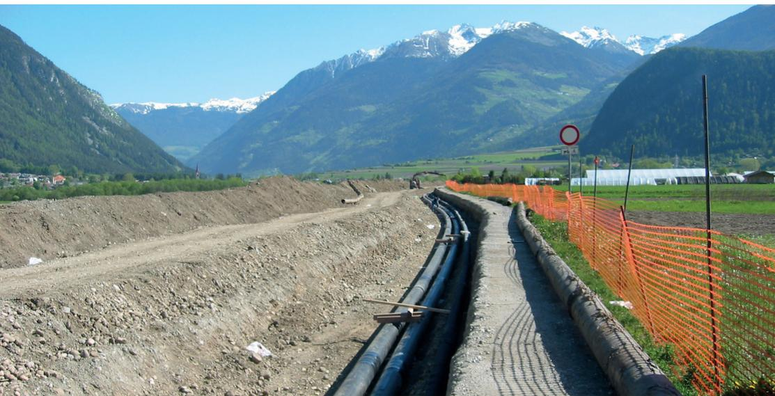
Das Erdgas gelangt durch **Transportleitungen** aus Stahl mit einem Betriebsdruck von bis zu 64 bar (Hochdruck) nach Südtirol. Betreiber des Transportnetzes ist SNAM Rete Gas. Das Erdgas im Transportnetz wurde noch keiner Odorierung unterzogen und ist daher noch geruchlos.
