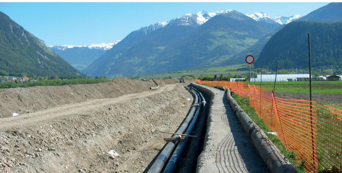
Il gas naturale arriva in Alto Adige attraverso **condotte di trasporto** in acciaio con una pressione di esercizio che arriva fino a 64 bar (alta pressione). Il gestore della rete di trasporto è SNAM Rete Gas. Il gas naturale all'interno della rete di trasporto non ha subito ancora nessun processo di odorizzazione e pertanto è ancora inodore.
