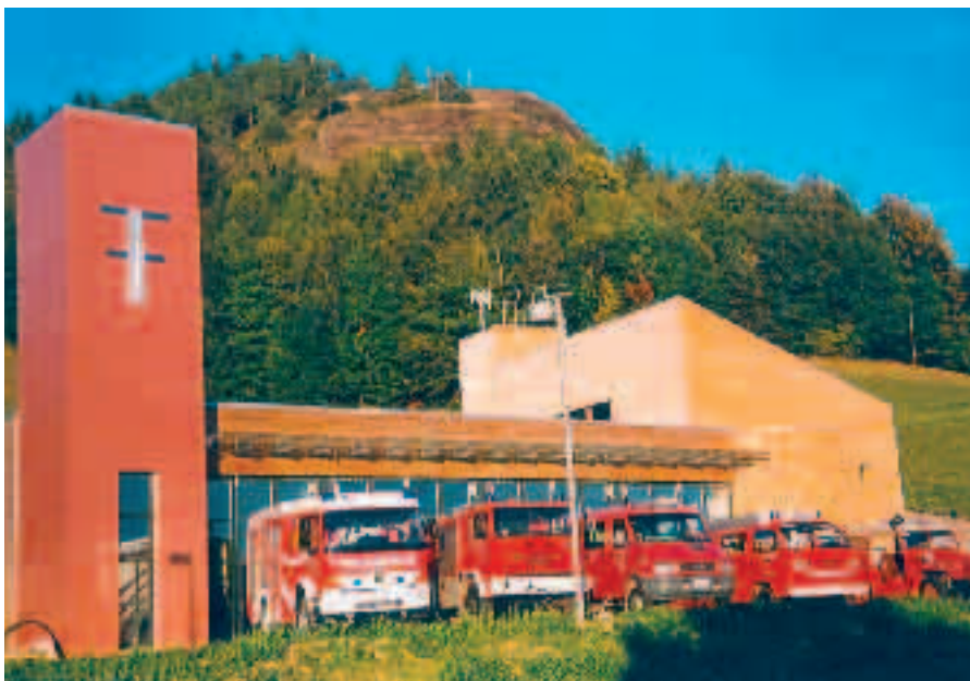
Neues Feuerwehrgerätehaus in Vöran
