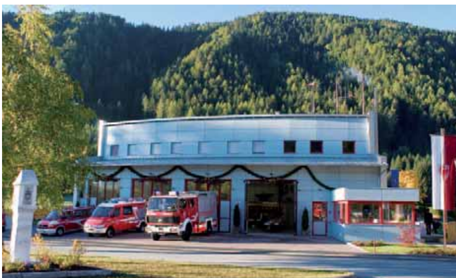
Neues Feuerwehrgerätehaus in Mareit
