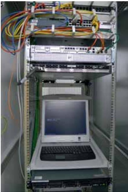
Kontroll- und Steuerstation des digitalen Alarmierungsnetzes
