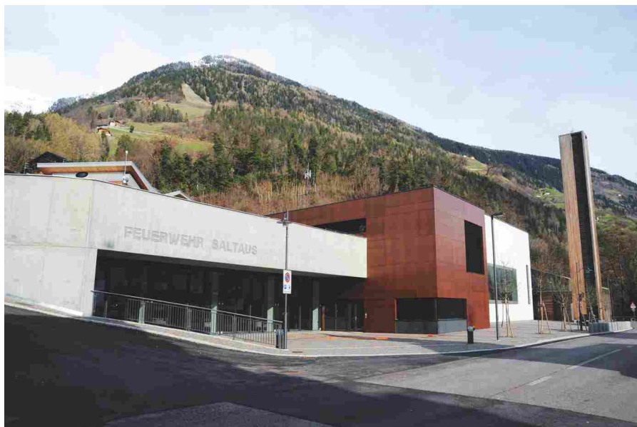
Neues Gerätehaus der Feuerwehr Saltaus
