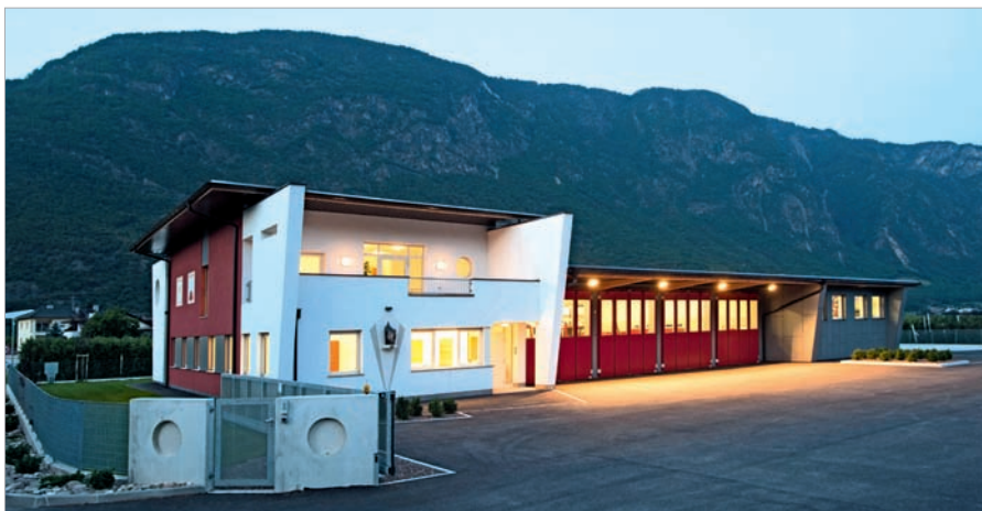
Neues Gerätehaus der Freiwilligen Feuerwehr Gargazon
