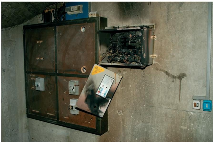
Kurzschluss im Verteilerkasten gerieten darunter liegende Kartone und Müllsäcke in Brand. Sie wurden ins Freie gebracht und dort gelöscht. Es entstand nur ein geringer Sachschaden.
