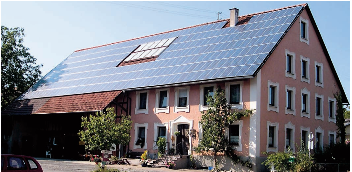
Die Möglichkeit, die Anlage mittels Folien abzudecken und dadurch eine Spannungsfreiheit zu erreichen, ist bei größeren Anlagen, wie bei der komplett bedeckten Fläche eines Bauernhauses, nicht praktikabel.
