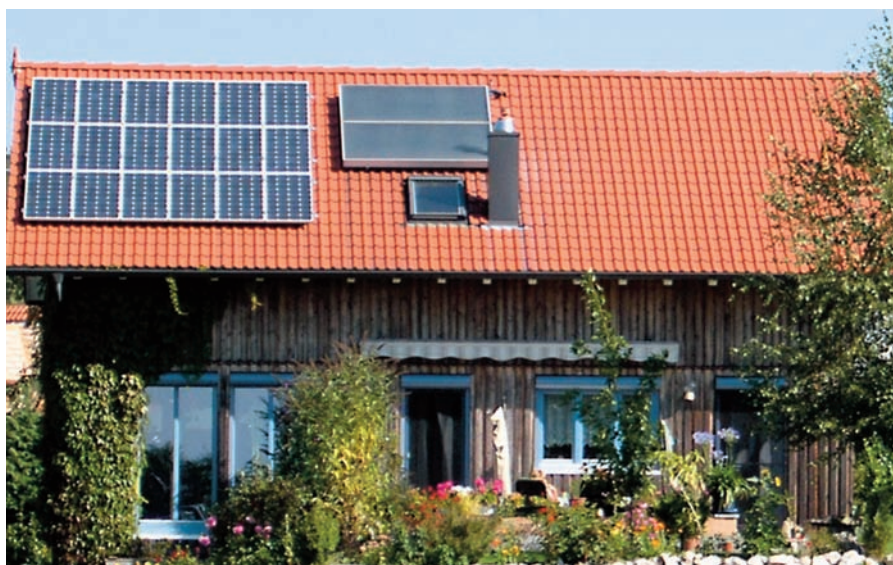
Photovoltaikanlagen (links) und solarthermische Anlagen (rechts) sind schon äußerlich leicht zu unterscheiden.
