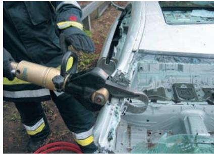
An dem geschaffenen Ansatzpunkt ist die Rettungsschere möglichst im rechten Winkel und weit geöffnet bis zum Anschlag an die Verstärkung zu bringen.
