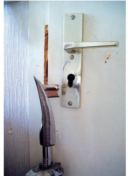
Ein hervorstehender Schließzylinder kann leicht mit dem Kuhfuß des Halligan-Tools abgesichert werden.
