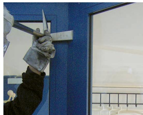
Der optimale Ansatzpunkt liegt bei Rauchschutztüren zirka zehn bis 15 Zentimeter unter der oberen Türkante. Die Schneide wird dort in den Türspalt getrieben und bei Bedarf tiefer eingeschlagen.
