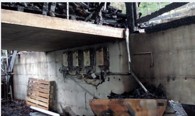
Vom Brand zerstörte Wechselrichter und Leitungen
