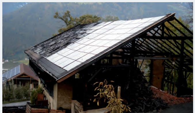
Die nicht zerstörten Module produzieren bei Lichteinfall weiterhin Gleichspannung
