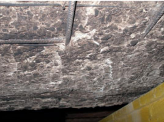
Eine der Gefahren bei einem Tiefgaragenbrand: Durch die große Hitze sind Betonteile an der Decke abgeplatzt. Die Stahlarmerung liegt teilweise frei. Hier droht das Versagen tragender Gebäudestrukturen.
