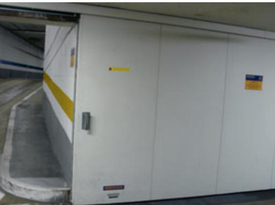
Automatisch schließende Brandschutztore verhindern die Ausbreitung von Feuer und Rauch. Gleichzeitig erschweren sie den Angriff über die Einfahrt und entlang der Pkw-Fahrspuren.
