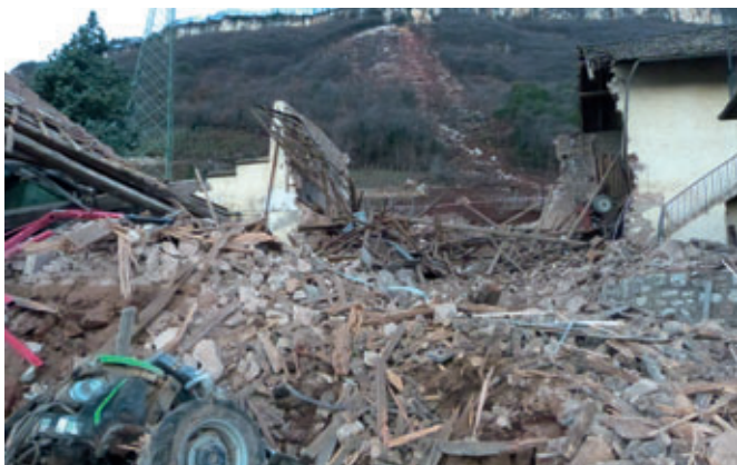
Zerstörtes Wirtschaftsgebäude Freisingerhof
