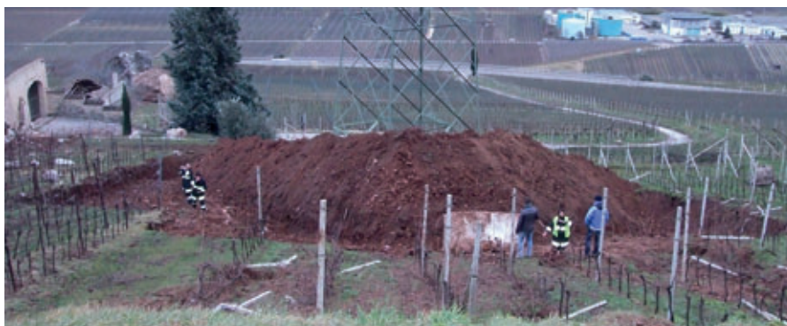
Schutzwall vor Hochspannungsmasten: Dieser hielt einen durch die Sprengung gelösten Felsblock auf
