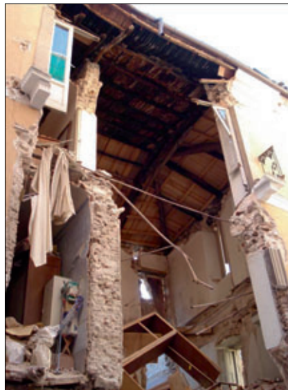
Bild 3: Absperren und Abstand halten bei Einsturzgefahr
