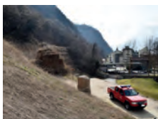
Vorbeugung: Errichtung einer Schutzdammwand
