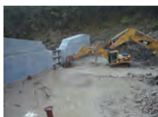
Regeneration: Instandsetzung Rückhaltesperre
