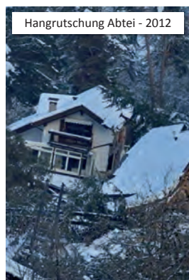
durch das Gelände bedingte Gefahren
